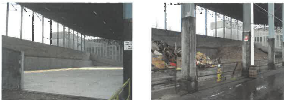
Area per la triturazione del legno trattato
