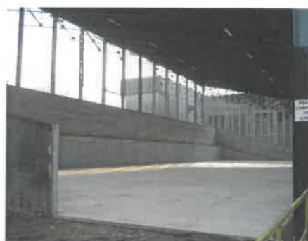
Area per la triturazione del legno trattato
